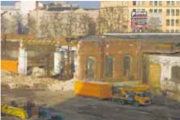
Bourání části jádrovny
